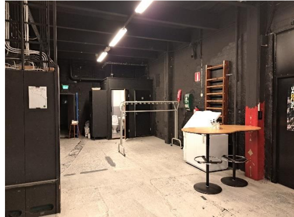
Kuva 9. Musiikkiosan lattia- ja seinämaalit sisältävät raskasmetalleja.
